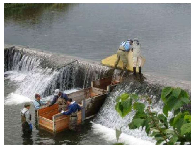
手づくり魚道の設置
