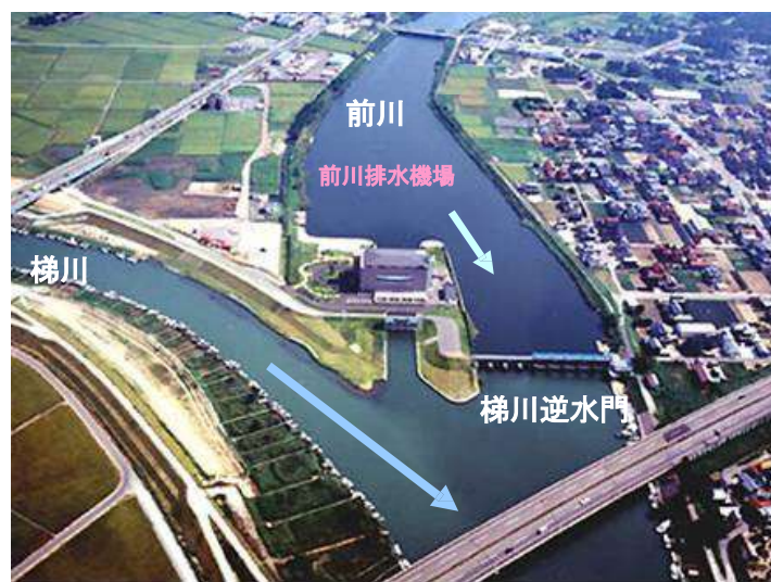
図 4-18 前川排水機場
