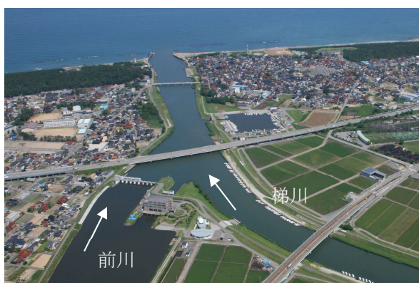
図 8-6 城南橋（河口より1.3km）付近
