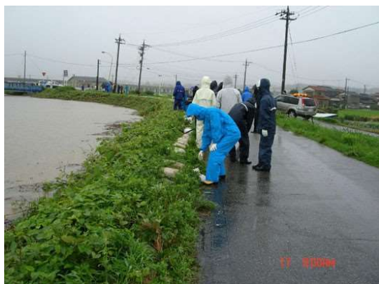
図 9-7 能美大橋左岸下流水防活動
