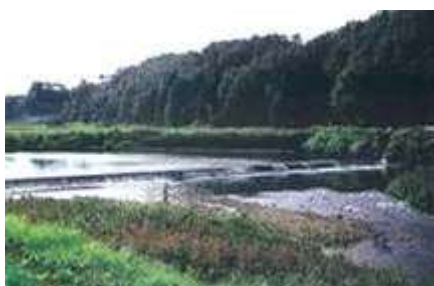
図 5-1 軽海用水頭首工
