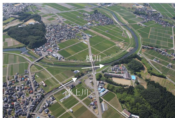
図 8-3 湊上川合流部（河口より10.7km）付近
