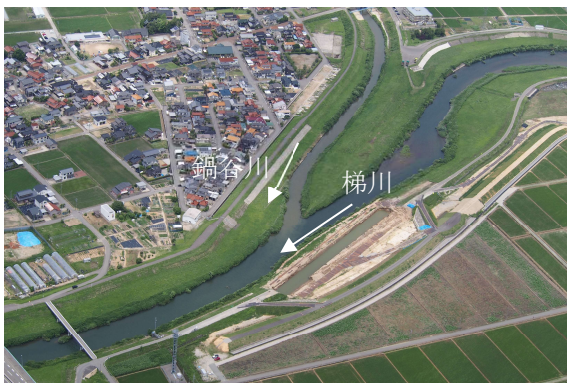
図 8-5 鍋谷川合流部（河口より7.5km）付近
