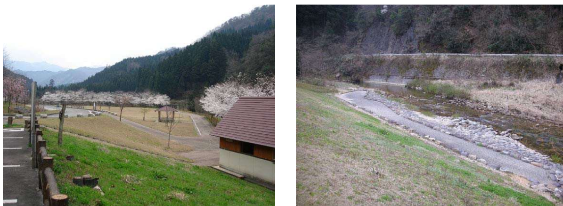
図 4-21 赤瀬ダム上流の環境整備
