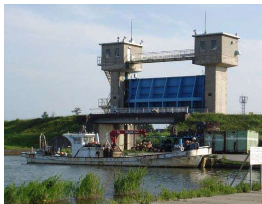
図 7-12 安宅漁港水門
