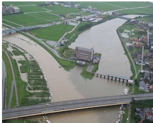
図 9-3 前川排水機場
