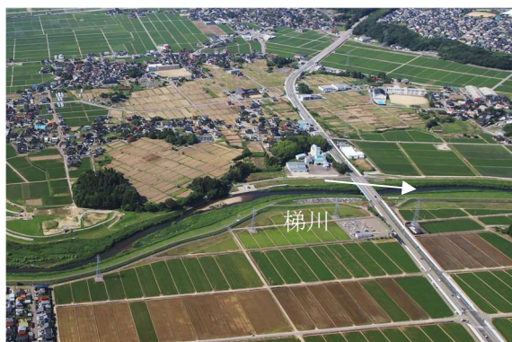
図 8-4 荒木田大橋（河口より9.2km）付近
