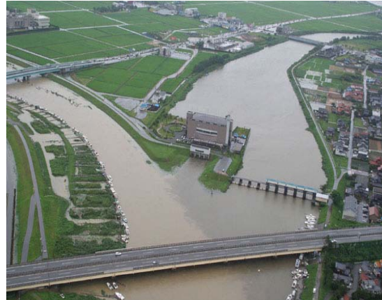
前川排水機場
