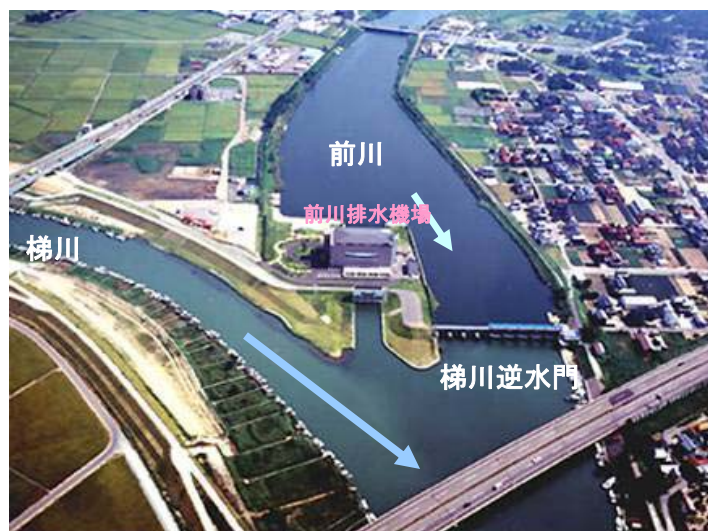
前川排水機場
