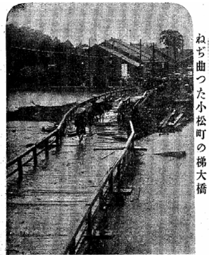
流出直前の梯大橋
