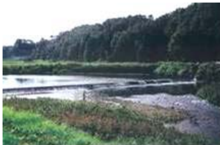
軽海用水頭首工
