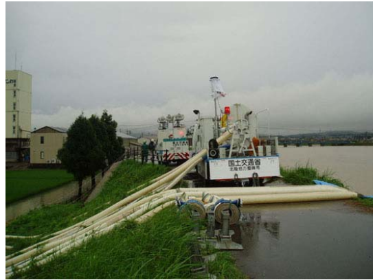
川田川樋管排水ポンプ車
