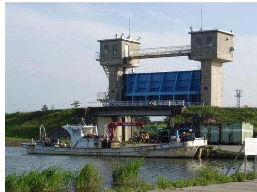
安宅漁港水門
