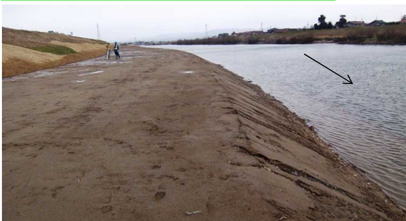
自立式鋼矢板護岸の施工状況（図15-1）
