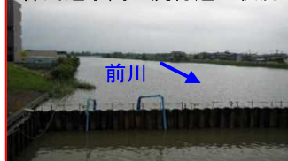
小松新橋上流右岸付近の状況
