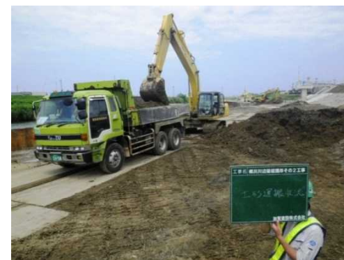
掘削土砂積み込み状況
