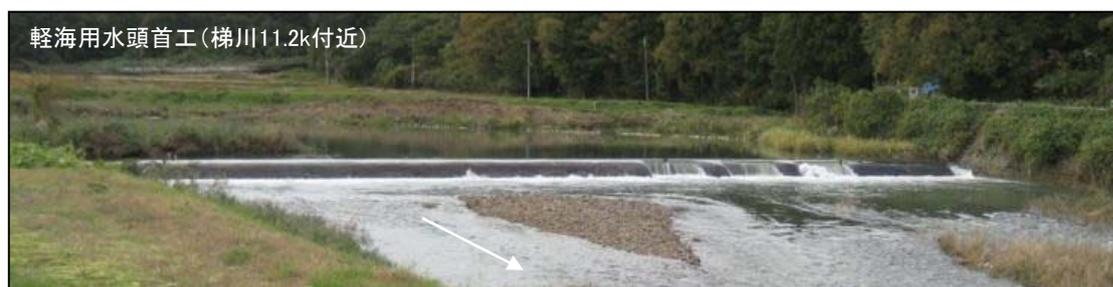
写真 3.15 魚類の移動阻害となっている取水堰（平成23年5月撮影）
