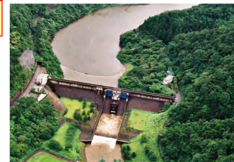
赤瀬ダム（S53竣工）
