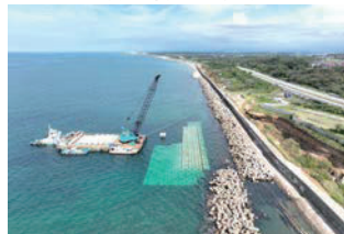
根固ブロック据付状況
