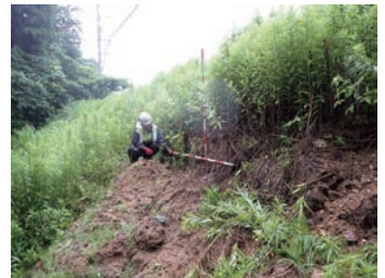
防災点検(法面等)
