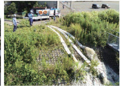
排水ポンプ車による排水状況
