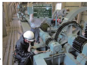
取水施設の定期点検
