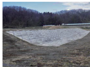
ブロック張りによる堤防法面の強化
