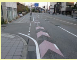
●自転車走行指導帯の設置 (国道159号)
