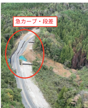
応急復旧後 (令和 6 年 7 月)
