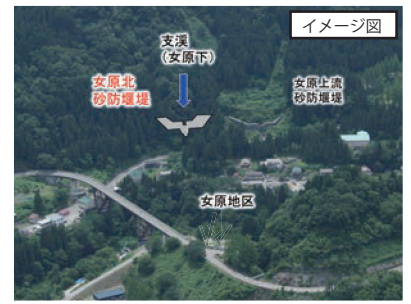
②女原北砂防堰堤
