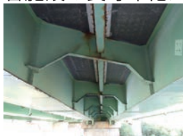
国道8号加賀大橋
