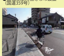
●自転車走行指導帯の設置 (国道359号)
