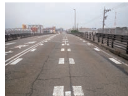
国道157号野々市市押野地先
