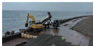
養浜材投入状況
