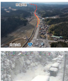
国道8号 平成30年2月大雪時の様子 (福井県あわら市中川)
