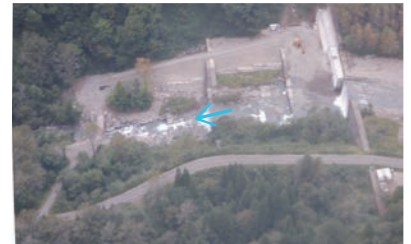
③猿壁砂防堰堤改築
