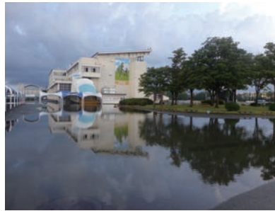
金沢競馬場浸水状況
