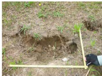
キツネの巣穴による堤防の損傷
