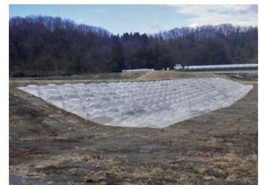
ブロック張りによる堤防法面の強化
