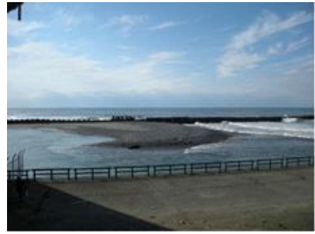
導流堤内の堆砂
