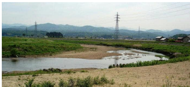
湾曲部堆砂状況
