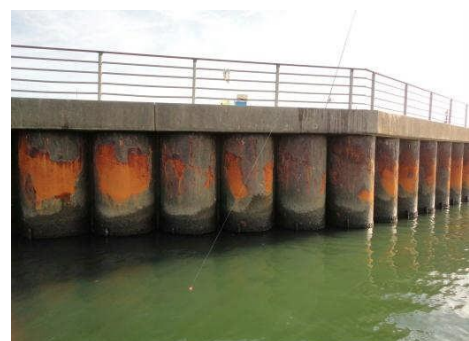
鋼管矢板護岸
