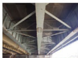
国道8号犀川橋(下り)
