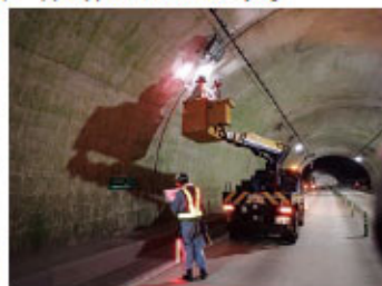
トンネル点検
