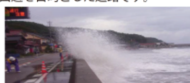
国道160号 越波による通行規制 （石川県七尾市大泊）
