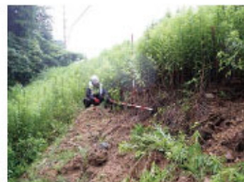
防災点検(法面等)
