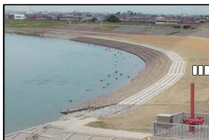
整備直後：護岸の上に土砂等を被覆
