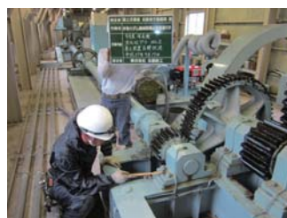
取水施設の定期点検
