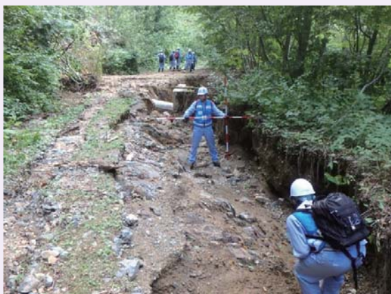
平成 28 年 9 月 8 日～14 日 (7 日間) 岩手県で台風 10 号による被災箇所の調査にあたる TEC-FORCE 隊員
