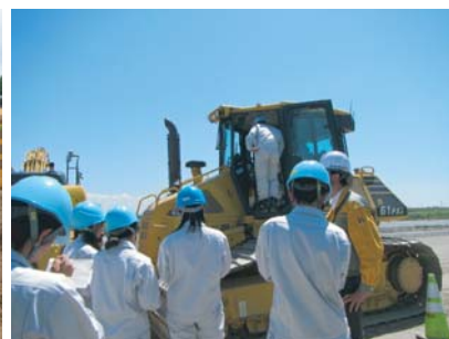
ICT 活用工事現場見学会（手取川）
