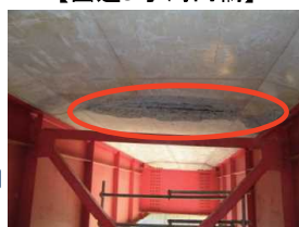
【国道8号 河内橋】
