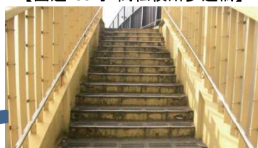
【国道159号 高松横断歩道橋】
