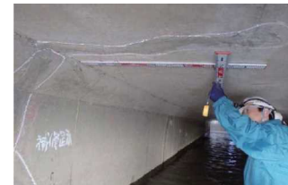
樋管の管内の老朽化を目視点検
