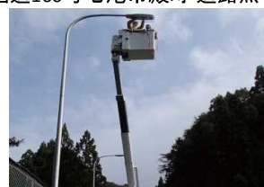
【国道160号七尾市殿町 道路照明灯】
