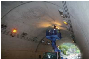
【トンネル点検】
