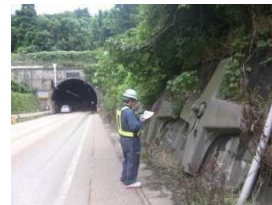
【防災点検(法面等)】
