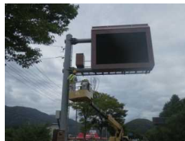
【道路附属物点検(道路情報板等)】
