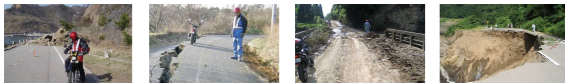
平成19年3月 能登半島地震による被災調査状況
