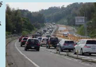
蓮代寺IC付近の混雑状況 (平成26年6月3日)
