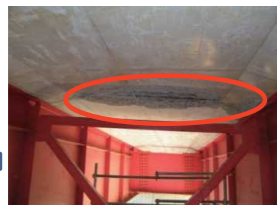
【国道8号 河内橋】
