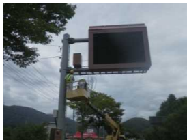
【道路附属物点検(道路情報板等)】
