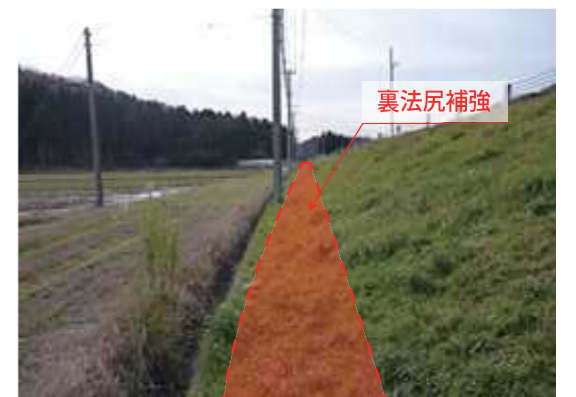
裏のり尻を補強し、越水した場合には深掘れの進行を遅らせることにより、決壊までの時間を少しでも延ばします。
