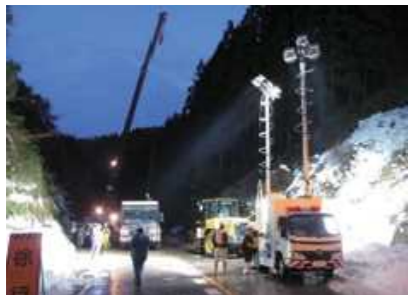
夜間の復旧工事現場を照らす照明車
