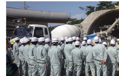
国道159号金沢東部環状道路神谷内トンネル 平成27年10月
