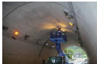
【トンネル点検】
