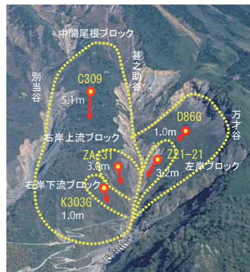
白山南西部の手取川上流甚之助谷地すべりの全景 赤矢印で示した方向に、地すべりブロックが移動しています 矢印は、S57.10~H27.10(33年間)の地すべりブロック移動方向と移動量 ●:移動量観測地点 ※(K303G、D86Gは平成16年以降) ※左岸大規模ブロックは、H17より観測開始。
