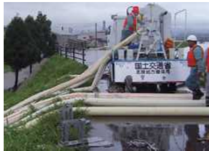
排水作業を行っている排水ポンプ車
