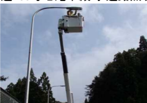
【国道160号七尾市殿町 道路照明灯】
