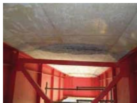
【国道8号 河内橋】
