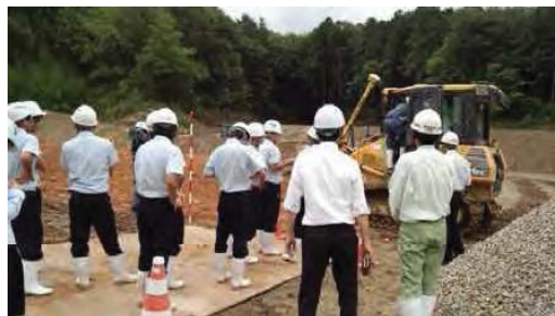
現場見学会（能越自動車道 七尾水見道路） 平成26年7月
