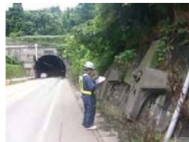
【防災点検(法面等)】
