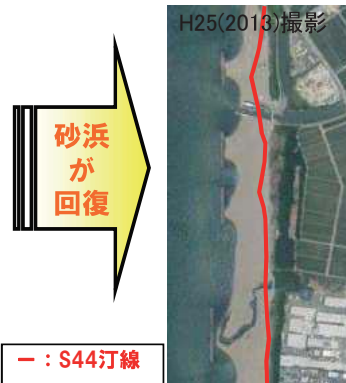
沖合施設整備後(H25.6) 松任工区相川新地先
