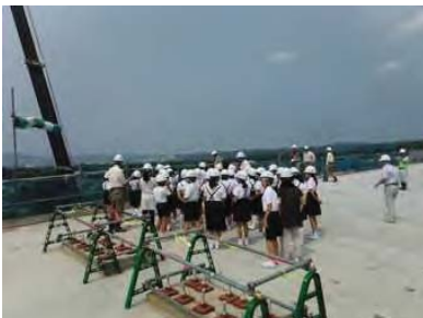
現場見学会（能越自動車道 七尾水見道路） 平成26年6月
