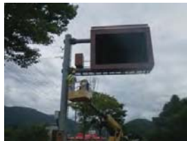
【道路附属物点検(道路情報板等)】
