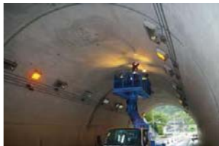
【トンネル点検】
