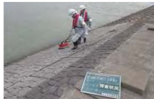
レーダ探査により護岸の空洞を点検
