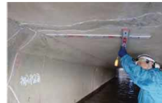
樋管の管内の老朽化を目視点検
