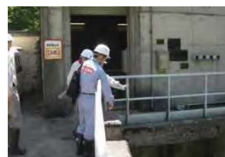
利水施設の定期検査
