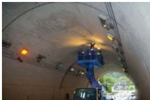
【トンネル点検】
