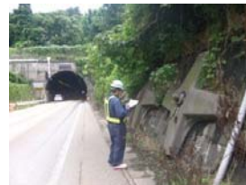
【防災点検(法面等)】
