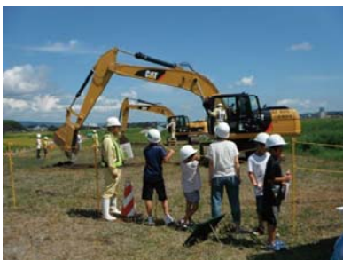
現場見学会（国道159号 七尾バイパス） 平成25年8月
