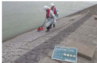
レーダ探査により護岸の空洞を点検
