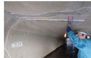
樋管の管内の老朽化を目視点検
