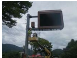
【道路附属物点検(道路情報板等)】
