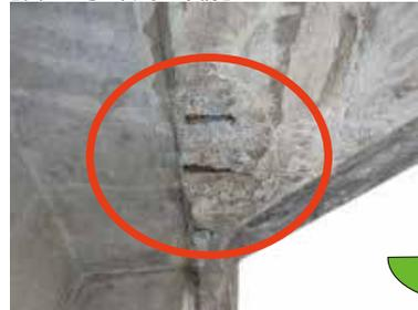
コンクリートが剥がれ、鉄筋の一部が見えている。
