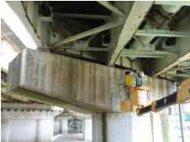
橋梁点検車により定期的に行う橋梁点検
