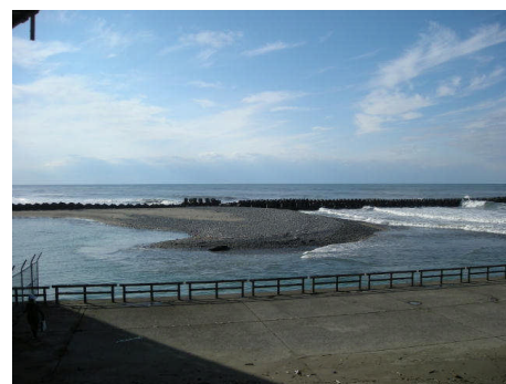
導流堤内の堆砂
