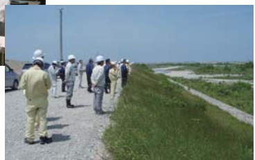
平成22年度の手取川巡視点検
