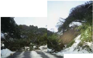
国道160号七尾市庵町の被災状況
