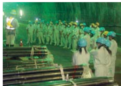
金沢東部環状道路(山側環状) 卯辰トンネル(II期線)工事現場 (平成22年7月8日 小松工業高等学校現場見学会)
