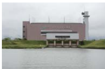
前川排水機場
