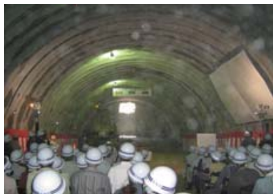
七尾水見道路工事現場 (平成22年6月11日 七尾トンネル貫通の瞬間を公開)
