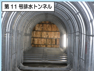
第11号排水トンネル
