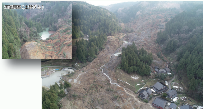
河道閉塞（土砂ダム）の発生（輪島市市ノ瀬町地先）
