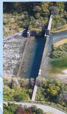
河内谷下流砂防堰堤
