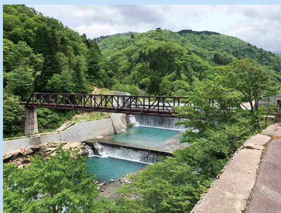
河内谷砂防堰堤
