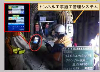
省人化となる自動測量・計測システム（トンネル工事施工管理システム）を用いて安全施工を実施しました。
