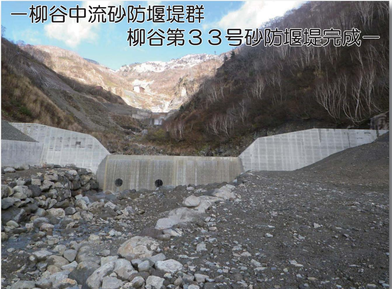
牛首川上流の柳谷は、溪岸の崩壊及び浸食が著しく、既にある砂防堰堤の多くは昭和初期に造られており、度重なる土石流出によってその一部が欠けるなどしています。
