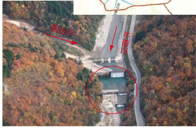
写真は、河内谷砂防堰堤の改築工事で、既設の砂防堰堤の補強・改築を行っています。今年度の工事では、仮締切により河川の水を右岸側に流し、左岸本堰堤を水を通し近くまで立ち上げます。また、左岸第2副堰堤の立ち上げ及び左岸側側壁部の間詰工の工事も実施します。
