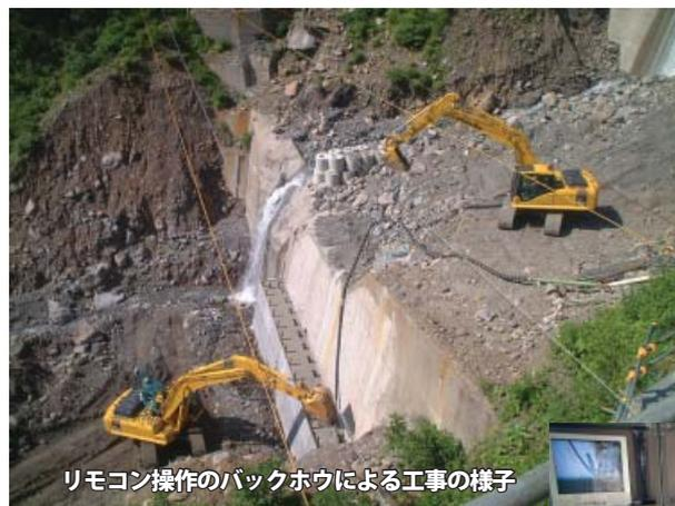
リモコン操作のバックホウによる工事の様子
