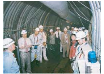
甚之助谷排水トンネルの見学
