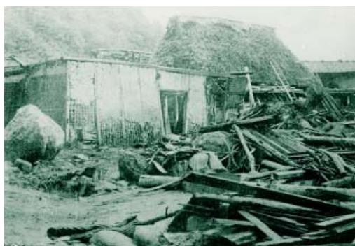
昭和9年の被災状況（白峰村・桑島地区）
