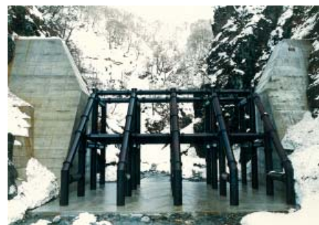
尾添川上流にある中ノ川第1号砂防堰堤
