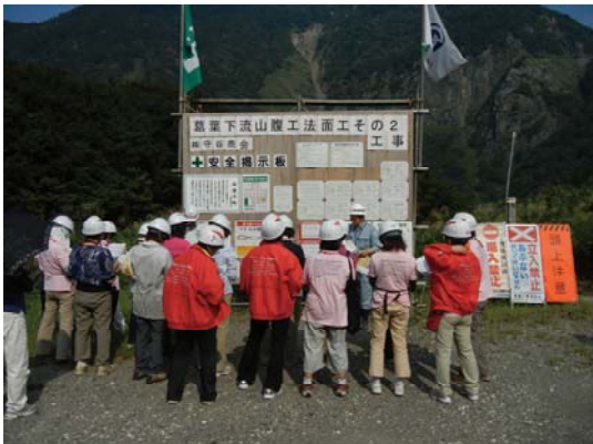
葛葉山腹工法面工工事現場(現場説明)
