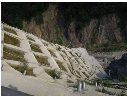
葛葉山腹工法面工工事現場
