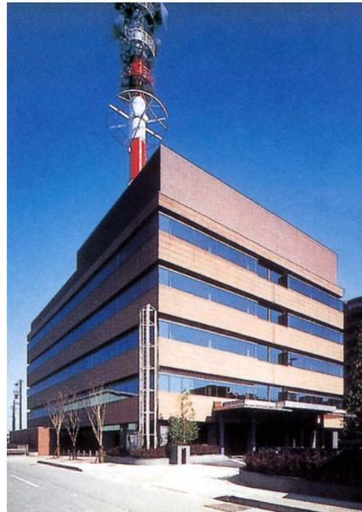
庁舎屋上の塔は高さ約58mの防災通信用無線鉄塔。さまざまな観測データをリアルタイムで収集します。
