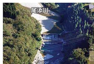
昭和27年竣工の尾添川・瀬戸砂防えん堤の補強対策として、副えん堤の施工を行います。
