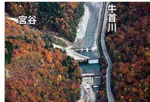
昭和18年竣工の牛首川・河内谷砂防えん堤の補強対策として、水叩きおよび本えん堤の補強を行います。
