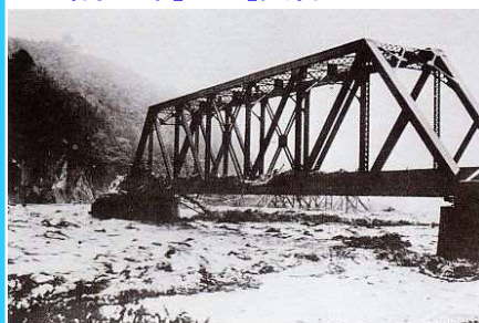
旧能美電鉄手取川橋脚の流失
