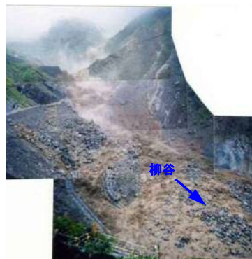
やなぎだに 柳谷の土石流災害状況
