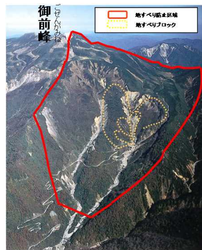
甚之助谷地区地すべり防止区域と地すべりブロック（詳細は次頁）
