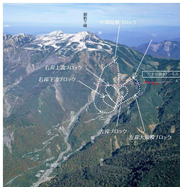
図2-14 甚之助谷地区地すべり全景
