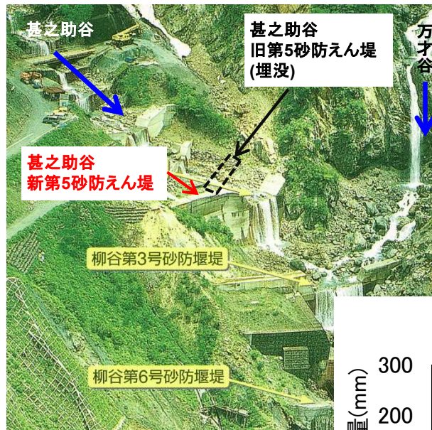
図2-3 現在の甚之助谷第5号堰堤付近の状況(平成8年)
