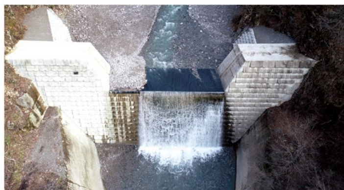
中ノ川第1号砂防堰堤 令和元年度本堤改築状況（写真3）
