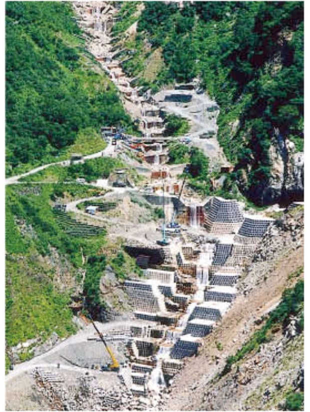
柳谷導流落差工(平成19年11月竣工)
