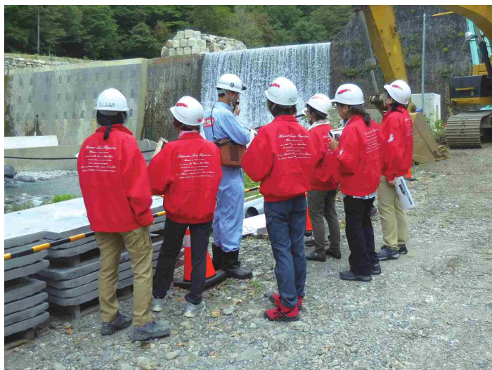
施工中の砂防堰堤を間近で見学
