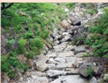
甚之助谷張石水路工(大正6年竣工)
