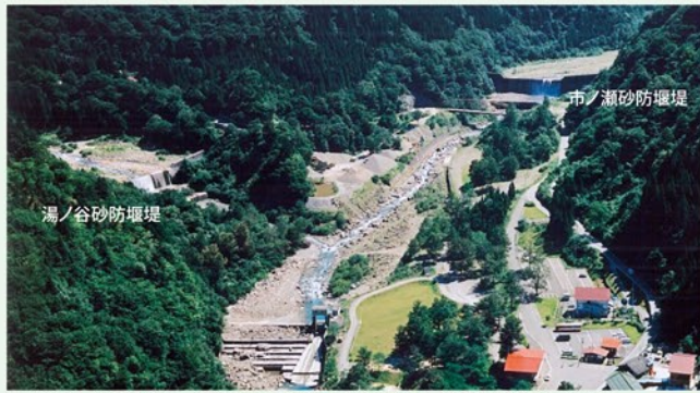
市ノ瀬(湯ノ谷合流点) 市ノ瀬堰堤(昭和29年竣工), 湯ノ谷堰堤(昭和31年竣工)
