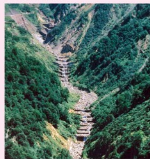
柳谷階段状堰堤(昭和2年～) 我国最初の階段状堰堤
