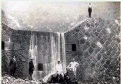
竜ヶ馬場溪第一号堰堤(大正15年竣工)
