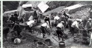
人力でコンクリートを製作・施工 現地にて採取した骨材とセメント・水の練混
