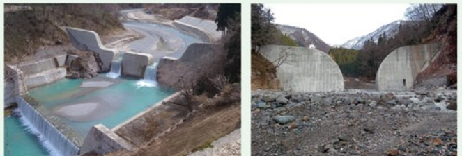
瀬戸堰堤(既設砂防堰堤のスリット化)
