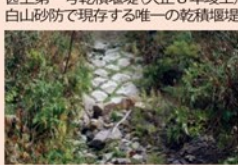
甚上第一号乾積堰堤(大正8年竣工) 白山砂防で現存する唯一の乾積堰堤
