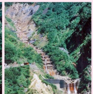
甚之助谷階段状堰堤(昭和6年～) 我国初期の階段状堰堤
