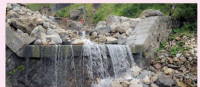
甚之助谷上流第十六号堰堤(昭和8年竣工)
