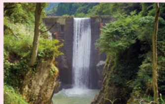
御鍋堰堤(昭和32年竣工)
