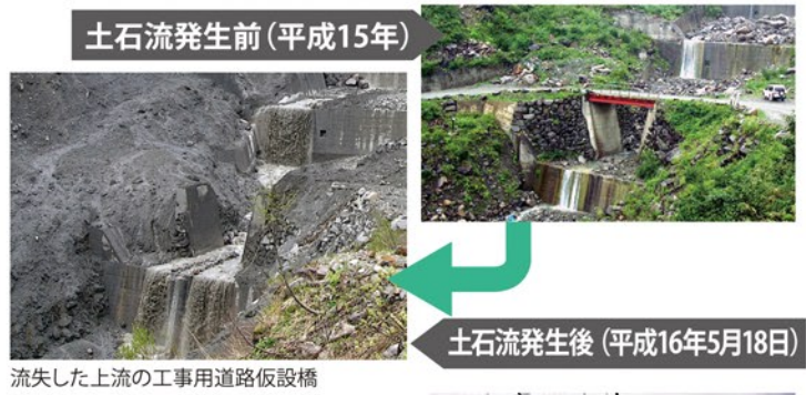
流失した上流の工事用道路仮設橋
