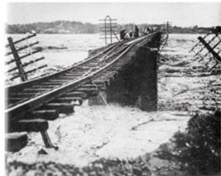
昭和9年災害 濁流に洗われる手取川鉄橋 (白山市)
