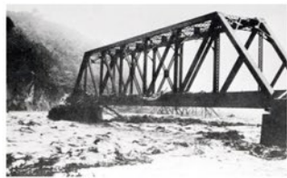
昭和9年災害 橋脚を奪われた能美電鉄の鉄橋 (白山市)
