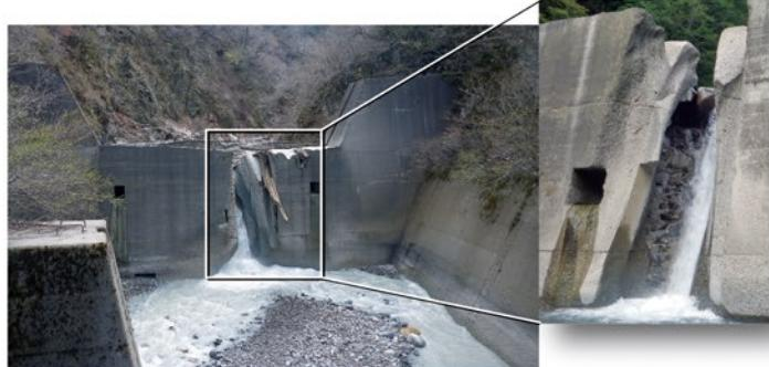
中ノ川第1号砂防堰堤 改築前損傷状況（写真2）
