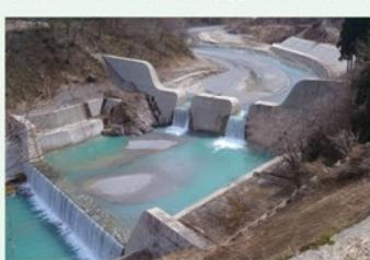
瀬戸堰堤（既設砂防堰堤のスリット化）
