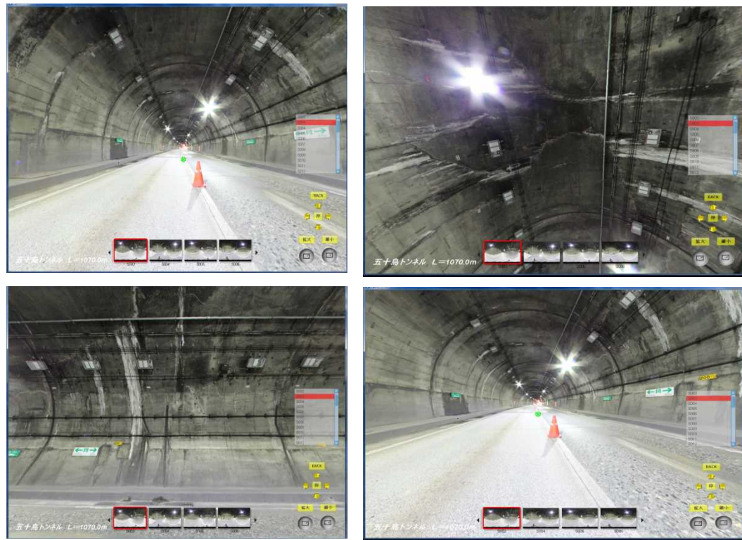
覆工壁面・路面連続画像
