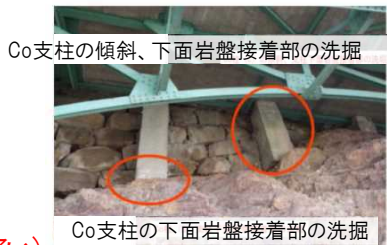
Co支柱の下面岩盤接着部の洗掘
