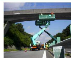
点検実施状況
