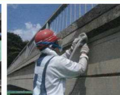
補修実施状況
