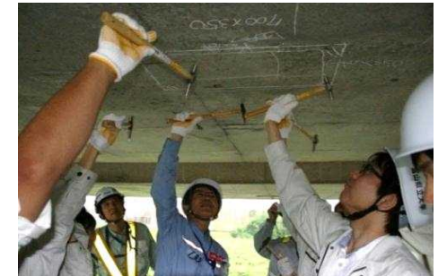
点検ハンマーによる打音調査を行っている状況
