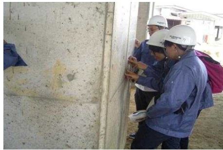
ひび割れ幅を測定している状況
