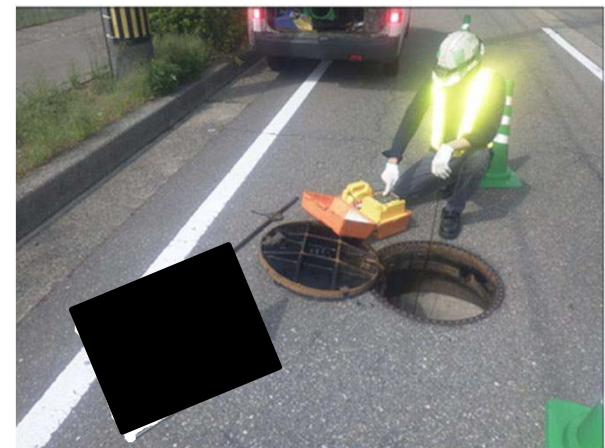
上水道 点検状況写真
