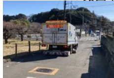
(空洞探査車による調査)
