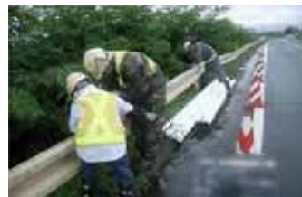
<防護柵の取替>
