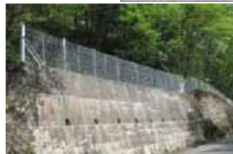
<落石防止柵の取替>
