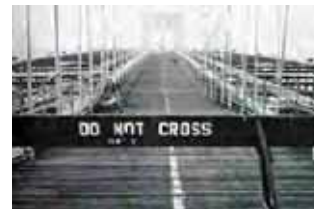
ケーブル切断事故後、通行止めになったフルックリン橋の歩道 （「高速道路と自動車」1981年11月から引用）
