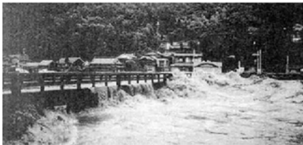
桁下高不足による支障事例
