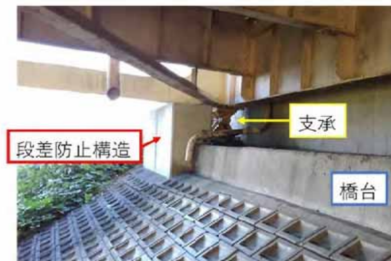
主桁下面の支承前面に設置した例
