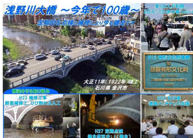
浅野川大橋 メンテナンス状況
