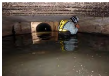
滞水した溝橋内部の目視点検
