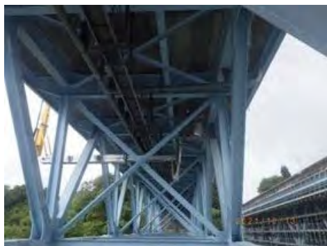
走行車線より差し込み
