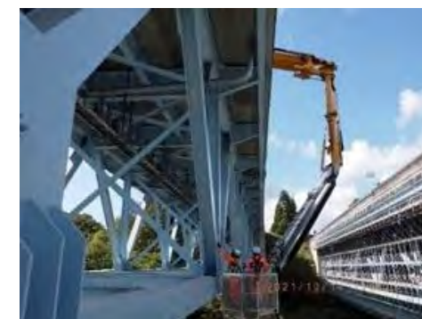
中分側下弦材点検状況
