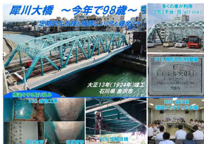
犀川大橋 メンテナンス状況
