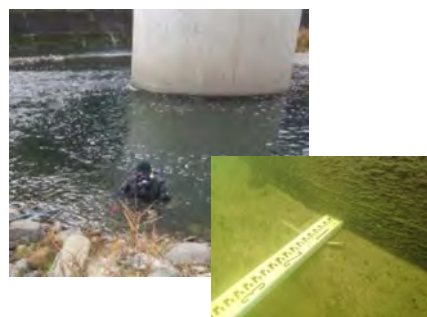
潜水調査による河床洗掘の把握
