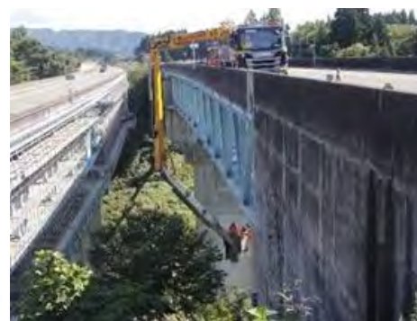
追越車線より差し込み
