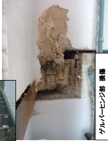
橋脚 断面欠損と鉄筋露出
