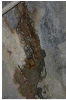
覆エコンクリートの剥落・貫通ひびわれ
