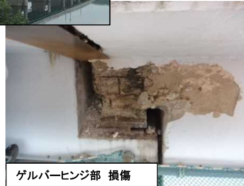
橋脚 断面欠損と鉄筋露出
