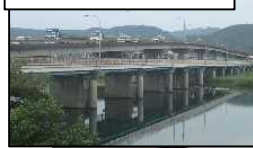
全景(手前側橋梁)
