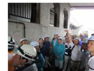
橋梁補修工事現場視察
