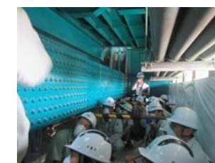
犀川大橋補修現場見学会
