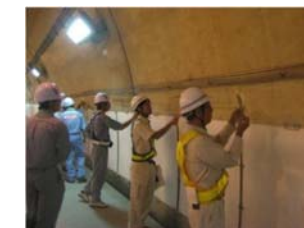
トンネル点検現地講習会
