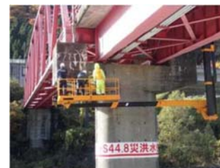
橋梁点検車による 近接目視点検
