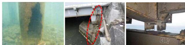
▲橋脚水中部の断面欠損 ▲PC鋼材の突出 ▲シェッド主梁端部破断
