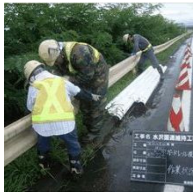
<防護柵の取替>
