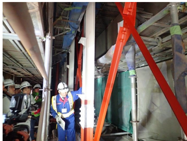
措置（補修）内容の現地確認
