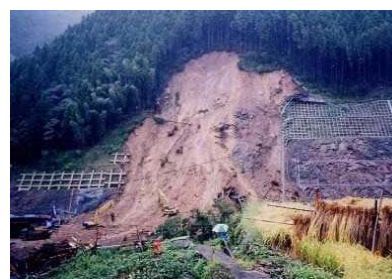
強風化・土砂化斜面での崩壊例
