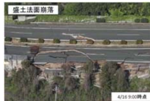
九州自動車道 益城町
