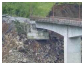
斜面変状による橋台の沈下
