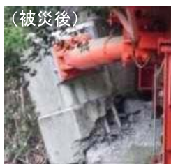
制震ダンパー取付部の損傷
