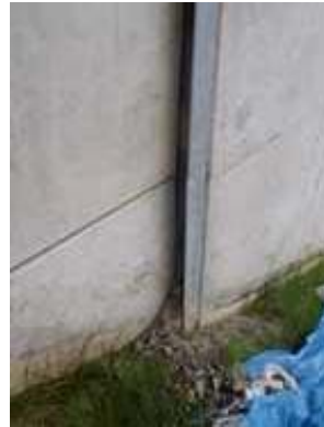
写真 土砂のこぼれ出し例
