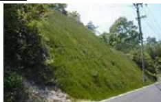
切土(のり面保護)
