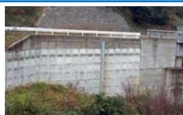
盛土(補強土壁)
