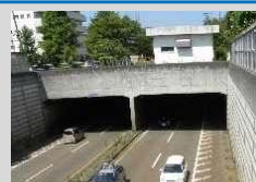
大型ボックスカルバート
