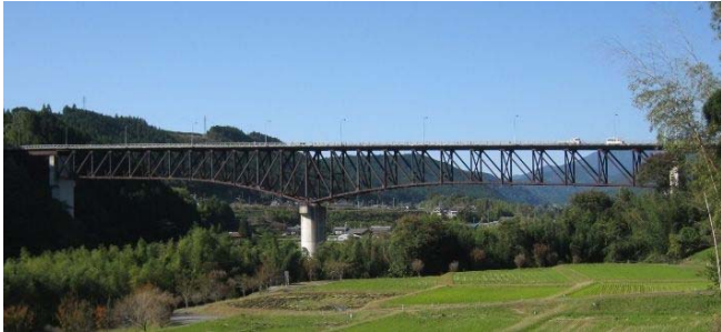
<乙姫大橋の状況>
