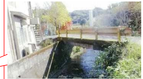
老朽橋の撤去
