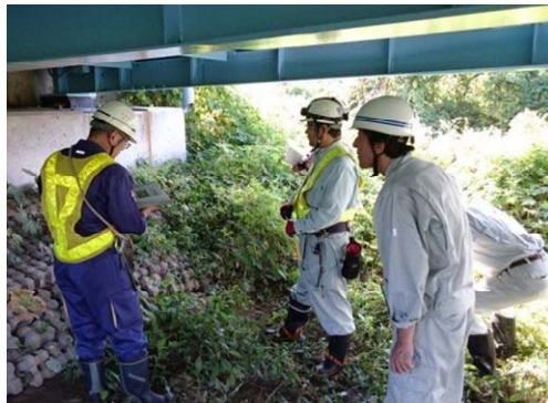
実地点検の状況
