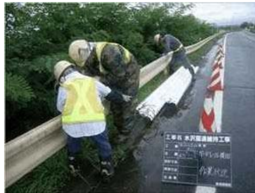
＜防護柵の取替＞
