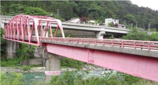
<音沢橋の状況>
